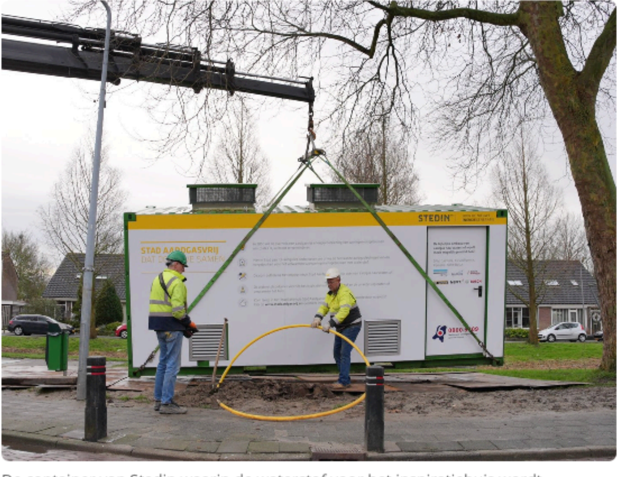
De container van Stedin waarin de waterstof voor het inspiratiehuis wordt opgeslagen
