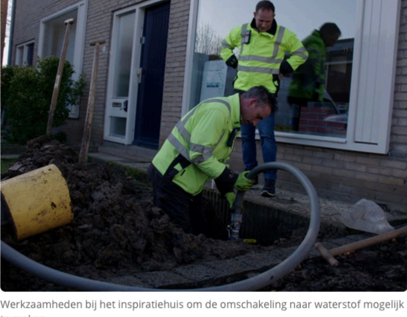
Werkzaamheden bij het inspiratiehuis om de omschakeling naar waterstof mogelijk te maken
