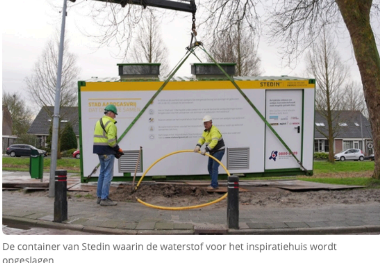
De container van Stedin waarin de waterstof voor het inspiratiehuis wordt opgeslagen
